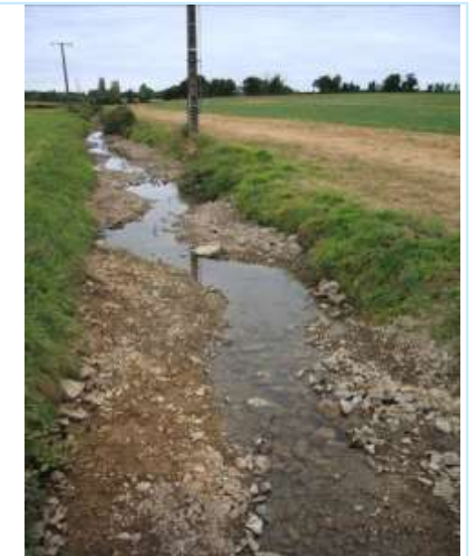
Photo de droite : après travaux
